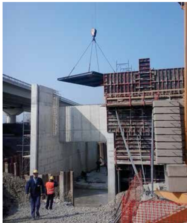
Figura 18 - fase di posizionamento delle paratoie a libro
