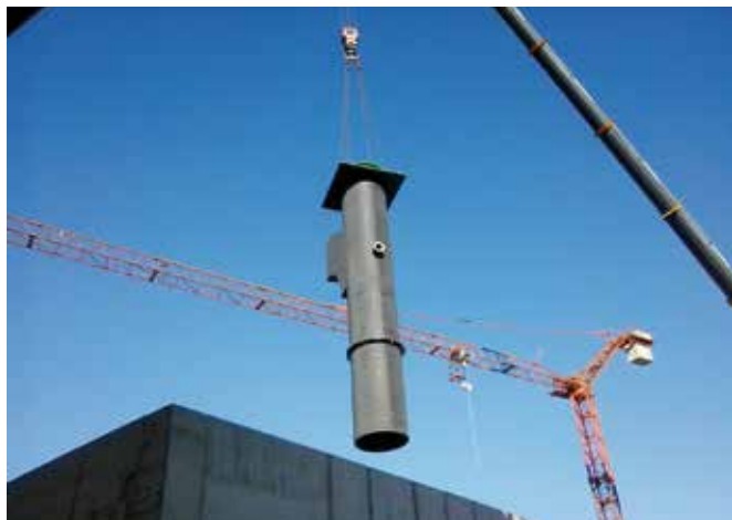
Figura 19 - fase di posa in opera dei tubi contenitori DN 1400 delle pompe idrovore
