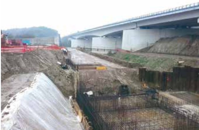
Figura 16 - armature platea di fondazione chiavica
