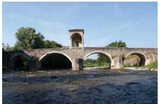
Antico ponte sul fiume Chiese a Pontenove, antica contrada di Bedizzole ( www.pontenove.it )
