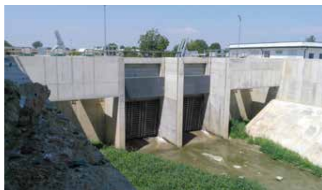
Figura 22 - vista dell'impianto da valle a lavori ultimati
