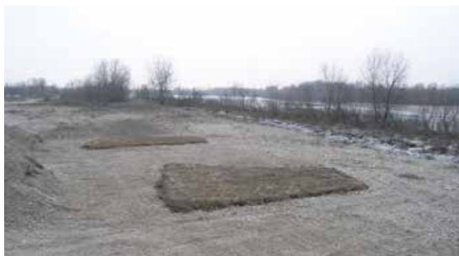
Figura 4: Moduli per l'impianto riempiti con terreno vegetale
